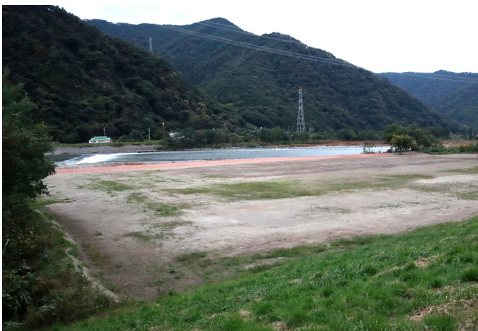
台風19号から1年経過した河川敷グラウンドの様子。現在は整備が進み当初よりも早く練習が可能になる見通しとなっている。写真撮影=坂元舞羽
