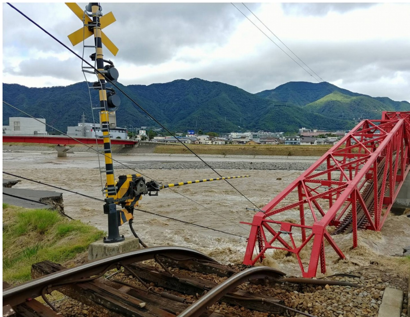
台風19号によって増水した千曲川は10月13日(日)の早朝、左岸堤防を侵食し、上田電鉄の鉄橋が崩落した。写真提供=上田電鉄
